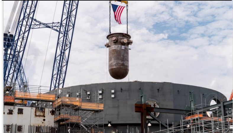
2. Blok usazení nádoby reaktoru – srpen 2016
