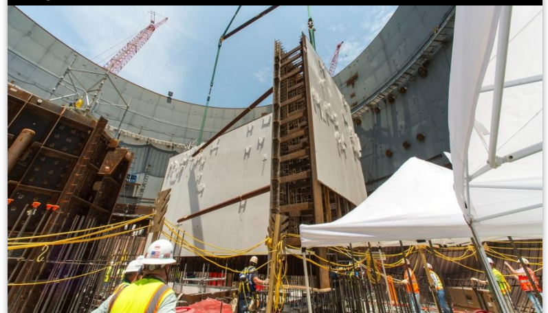
Vogtle 4. blok usazení modulu CA05 – červen 2016
